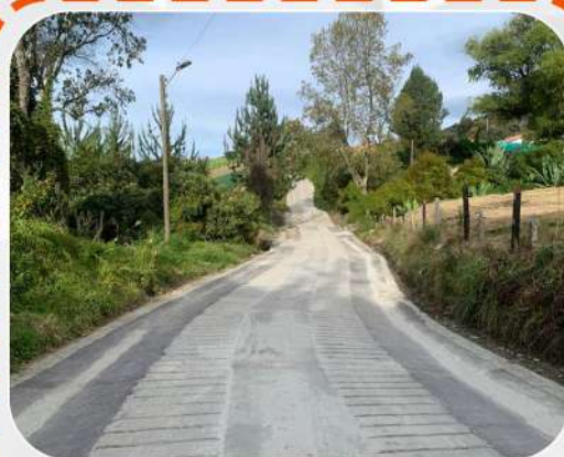
Con una inversión de 60 millones de pesos, construimos 90 metros de placa huella que conduce a la institución educativa Técnico Industrial
