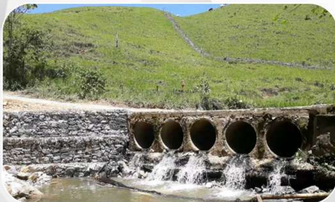
Se construyeron gaviones para repotenciar el puente Rancho Largo, en el sector La Campiña, vía Autopista-La Danta
