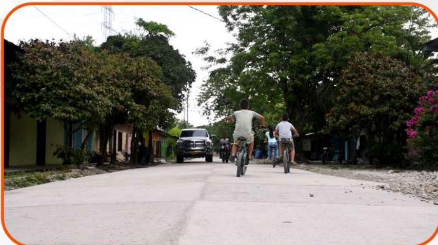
Pavimentación 3 vías urbanas en el corregimiento San Miguel. Trabajo articulado entre la JAC, Argos y Municipio
